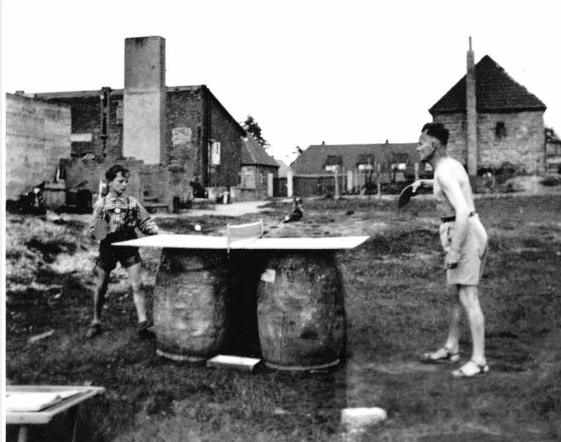
Unter einfachen Verhältnissen und schwierigen Bedingungen blieb trotzdem Zeit zu einem Tischtennispiel. Instandgesetzt und schon von Flüchtlingen bewohnt, im Hintergrund: links das ehemalige Labor der Luftwaffenforschungsstelle, in der Mitte die ehemalige Remise, rechts das ehemalige Trafobüro.
